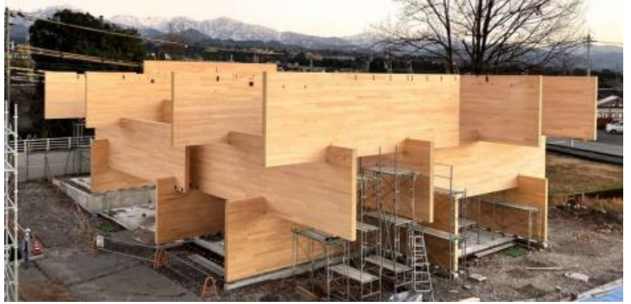
ストローグ(株)本社 井桁組の CLT パネル
