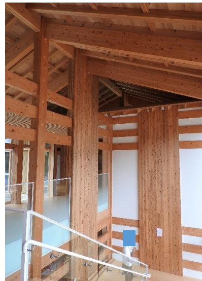
屋根下まで通しの柱と CLT
